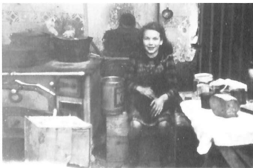
Labaroche Henzell Notre "Chez nous" aménagé après déblaiement des gravats et mise "hors d'eau". Fernande a 13 ans.
