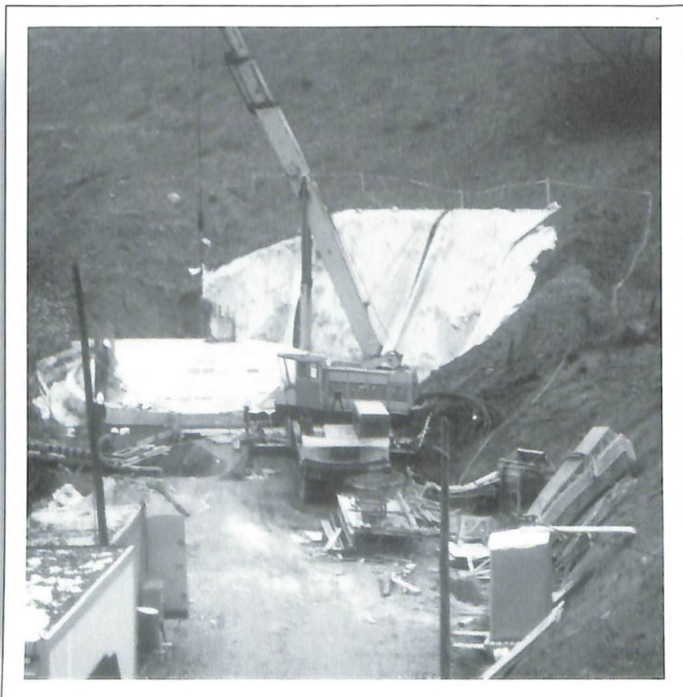
> Construction du nouveau réservoir en 1993
