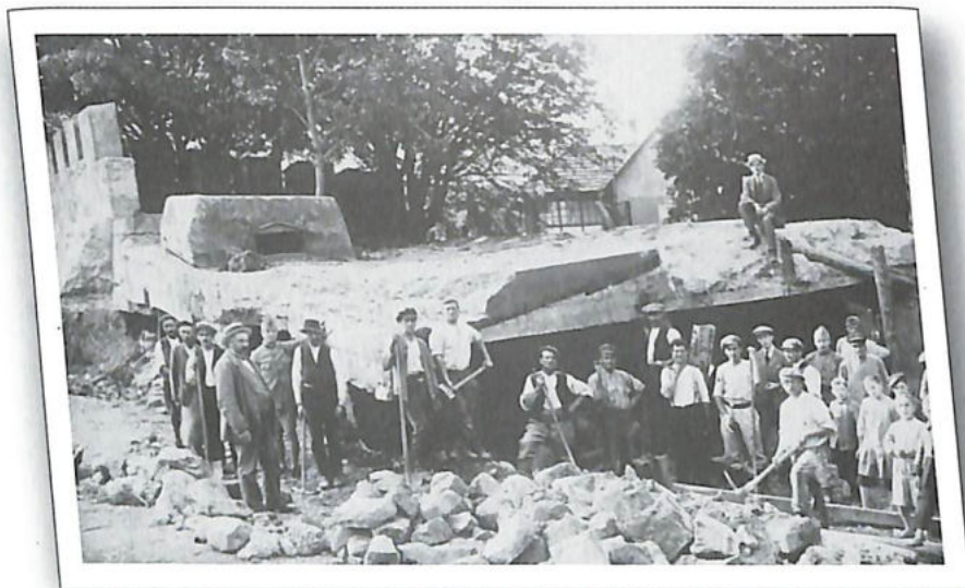
> Démolition du téléphérique en 1919
