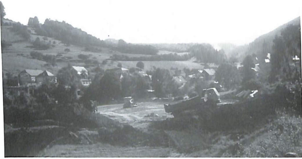
> Construction et mise en place du terrain de football en 1982
