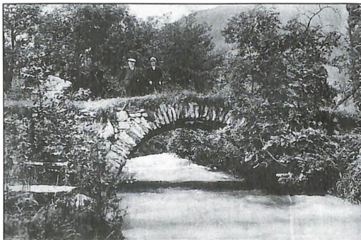
Le pont romain sur la Béhine, à Froide-Fontaine
