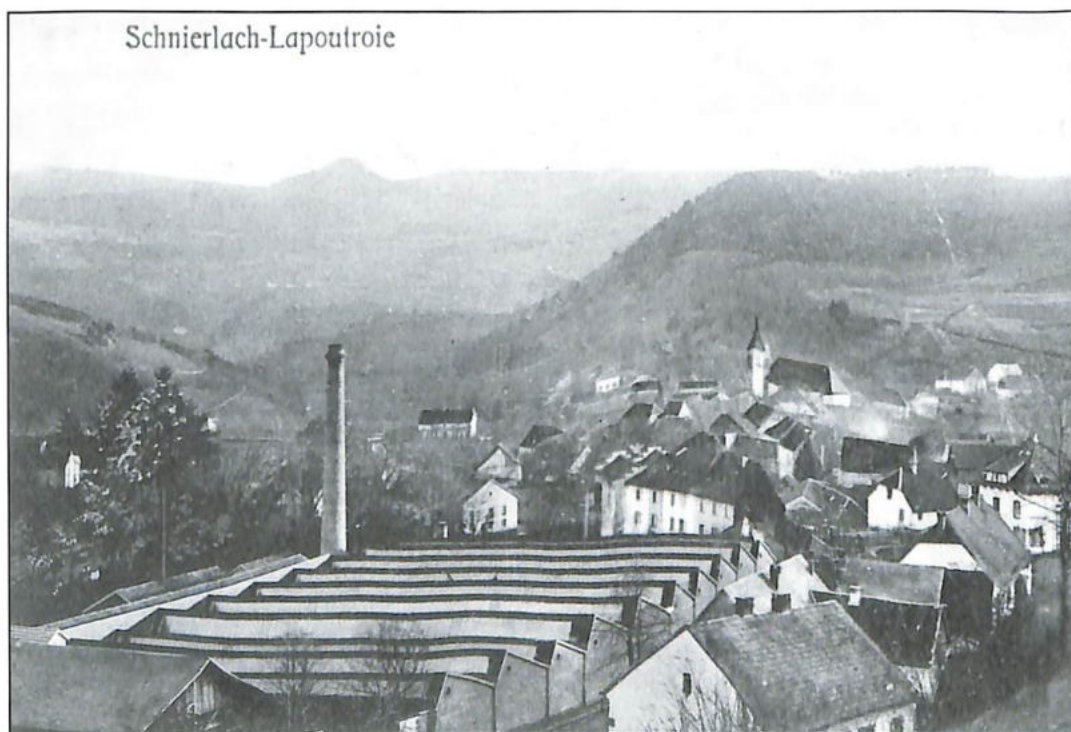
Ancienne filature, l'usine existe encore aujourd'hui, on note la présence de la cheminée
