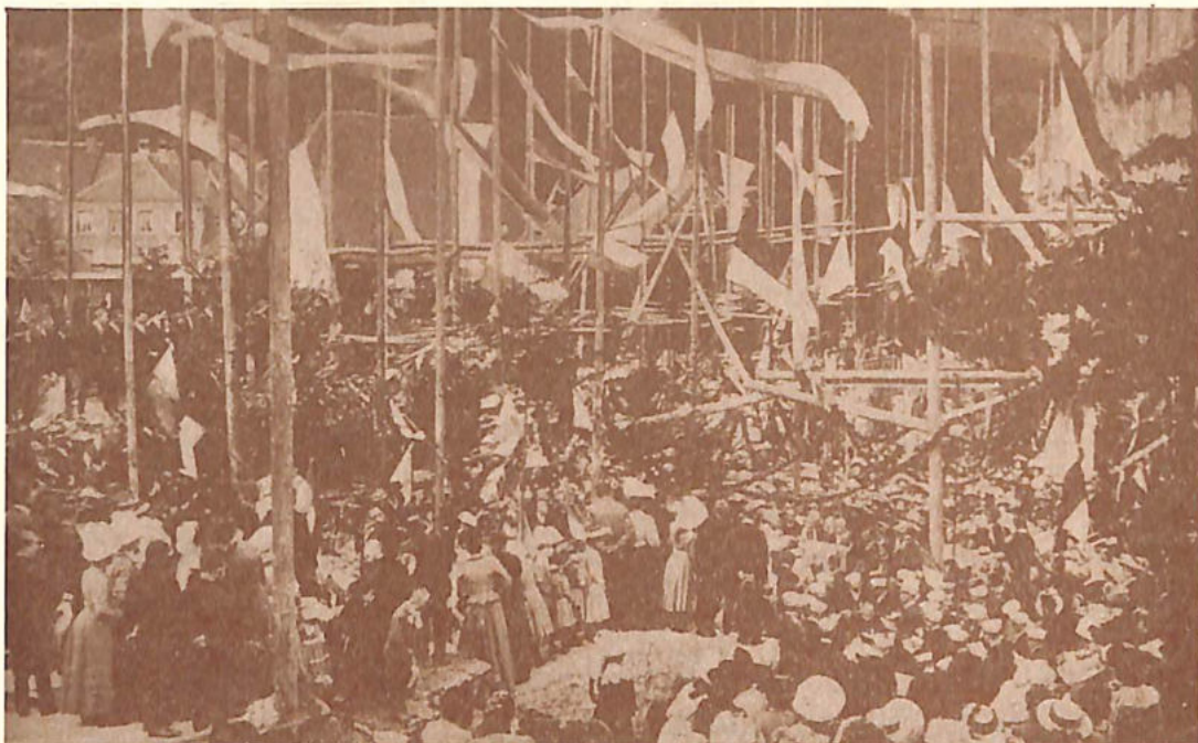
Pose de la 1ère pierre de la nouvelle église en 1911.
