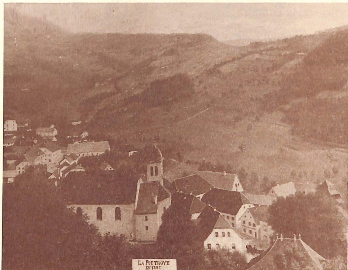
3ème église après transformation du clocher en 1807.
