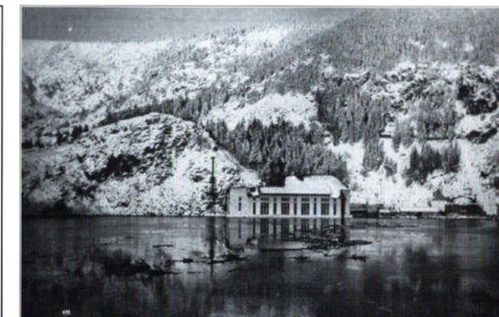
Vue d'ensemble de l'usine juste après l'accident du 4 janvier 1934, prise de la digue du Lac Noir.
