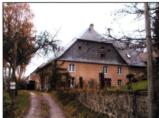
L'ancienne ferme PETITDEMANGE à Ribeaugoutte (1773)
