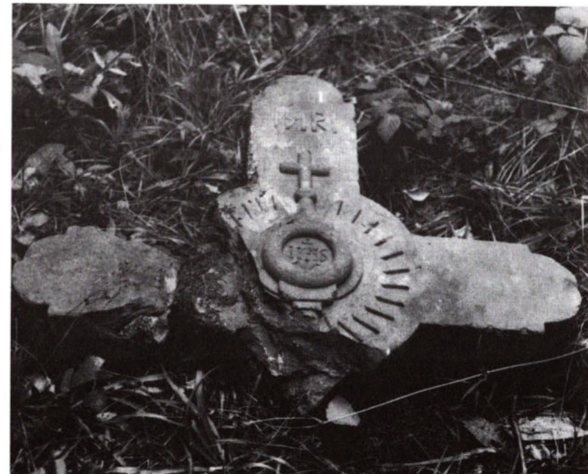
La Croix du Noirmont avant restauration
